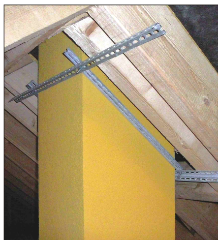
detail kotvení ke krovu
