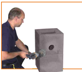
obr. 3 Vyřezání otvoru pro připojení
