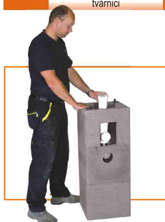
obr. 6 Osazení kontrolního otvoru
