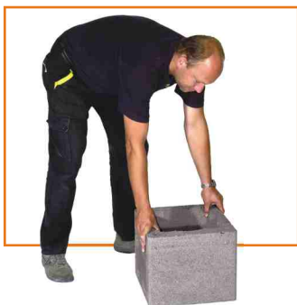
obr. 1 Osazení první komínové tvárnice na základ opatřený izolací proti zemi vlhkosti
