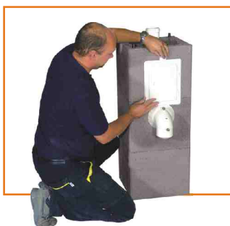
obr. 7 Osazení dvířek
