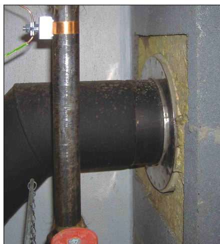
detail vložené redukce
