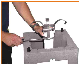
obr. 9 Montáž středící objímky
