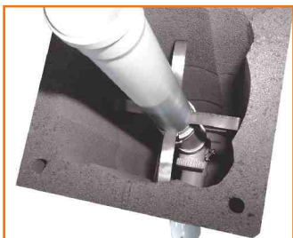
obr. 10 Detail středící objímky
