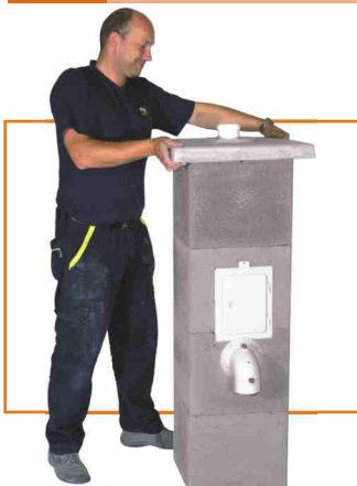
obr. 11 Osazení betonové krycí desky
